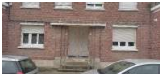
Le bâtiment concerné
