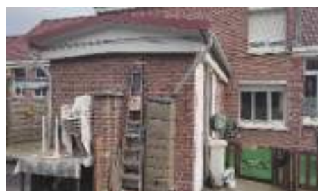
isolation extérieure de la salle de bains
