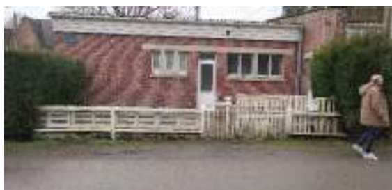
Devant le futur logement
